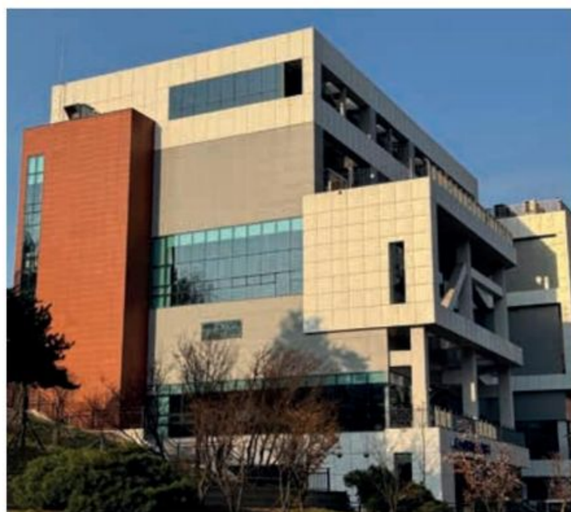
ALCALAGRES / Fachada ventilada realizada con la serie Tecnika en color blanco y formato 60x60 cm.; en color gris y formato 60x60 cm. y en color mango y formato 30x60 cm. / Foto: Alcalagres.
